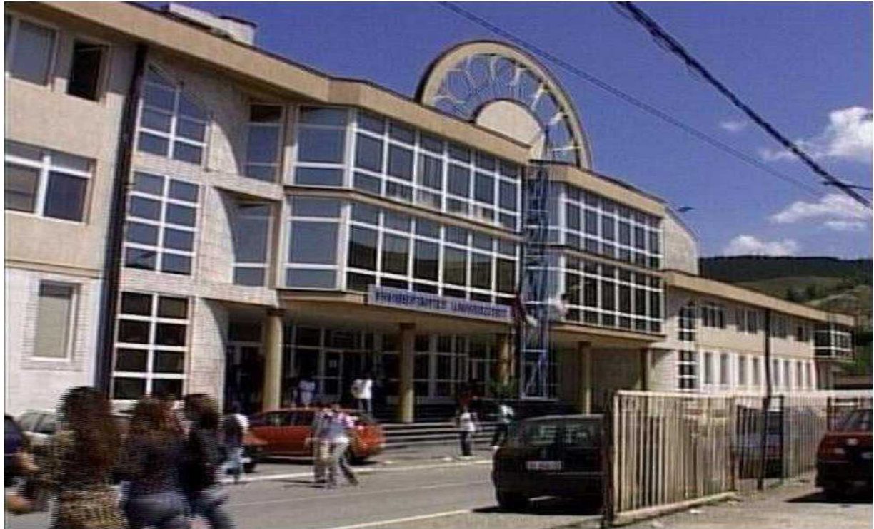
Slika 2. Glavna zgrada Državnog univerziteta u Novom Pazaru koja je smeštena u Ulici Vuka Karadžića bb
