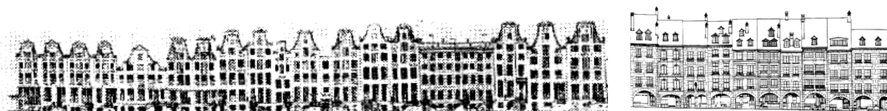
Slika 78: Front ulice pored kanala Heren Gracht u Amsterdamu sa ujednačenim ritmom pročelja objekata i motivom ponavljanja završetka krova, i front ulice Gerechtigkeitsgasse-Kramgasse u Bernu sa varijacijama dominantnih lučnih otvora u prizemljima i igrom krovnih prozora i dimnjaka.
